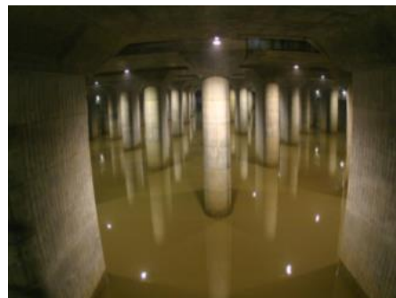
稼働中の調圧水槽（地下神殿）
