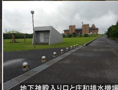
地下神殿入り口と庄和排水機場
